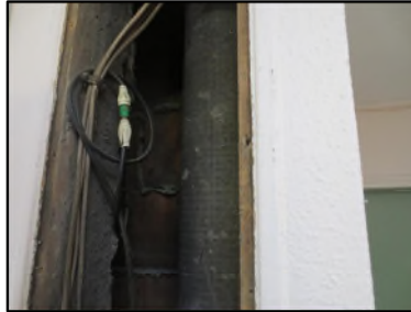
Photo N° 645 AMIANTE CIMENT -- GAINE TECHNIQUE eau usé - RDC Gaines & coffres verticaux Chute E.U.(Fibres-ciment)
